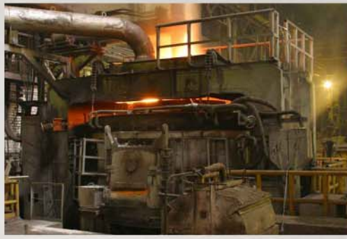
ДППТУ-20. ОАО "Тяжпрессмаш", г. Рязань. Реконструкция ДСВ-20.
