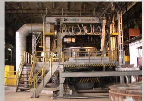
ДППТУ-12 ОАО "ПО УСОЛЬМАШ", г. Усолье-Сибирское
